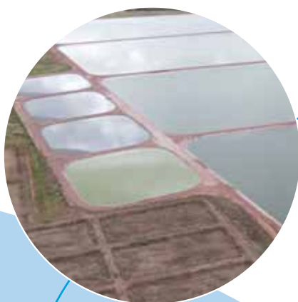
Station d'épuration de Berrchid
