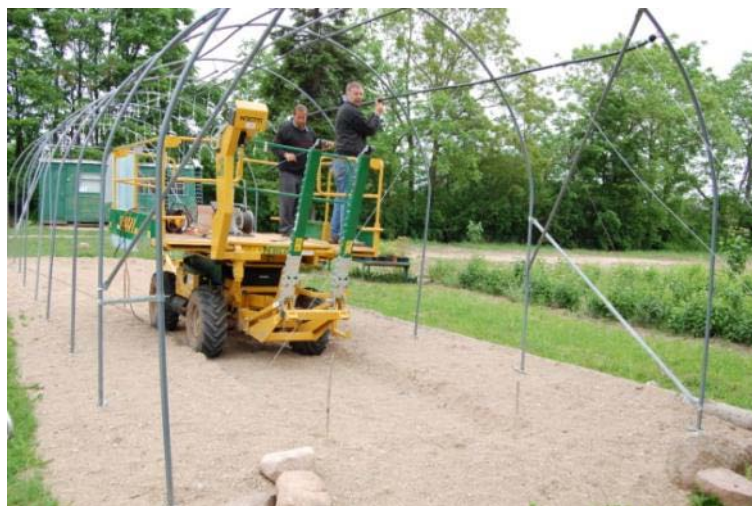
Augu pavairojamā tuneļa karkasa izveide
