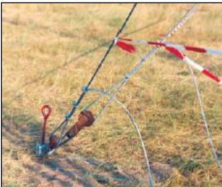
5) Uchycení stožáru k zavrtávací kotvě
