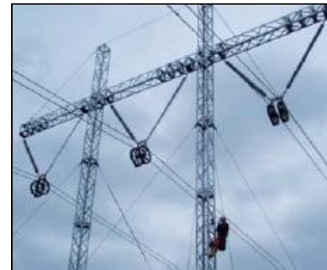
6) Montáž vodičů na provizorní vedení NPT
