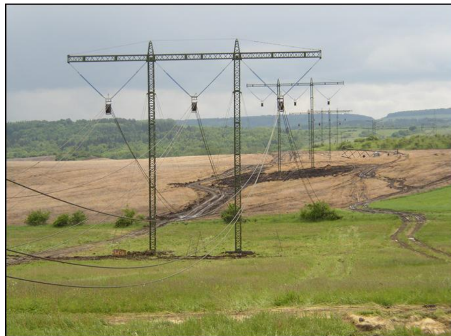
Tažení vodičů na náhradní přenosové trase Havárie vedení 400kV V441 – Maštov
