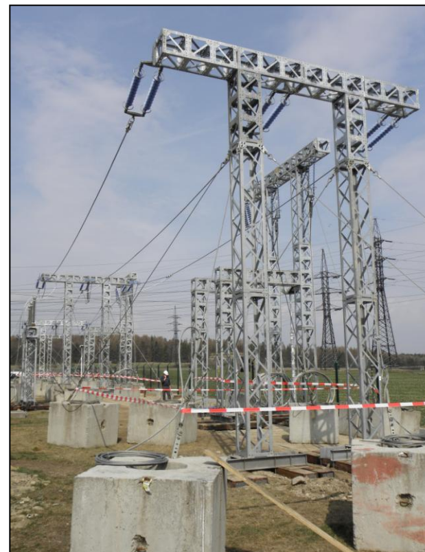
Rekonstrukce R 110kV Nahrazení přípojnic v rozvodně Horní Životice
