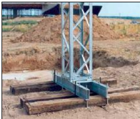
5) Uchycení stožáru k zavrtávací kotvě
