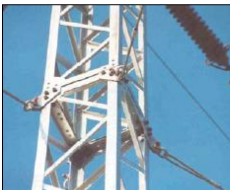
4) Uchycení stožáru ve výšce
