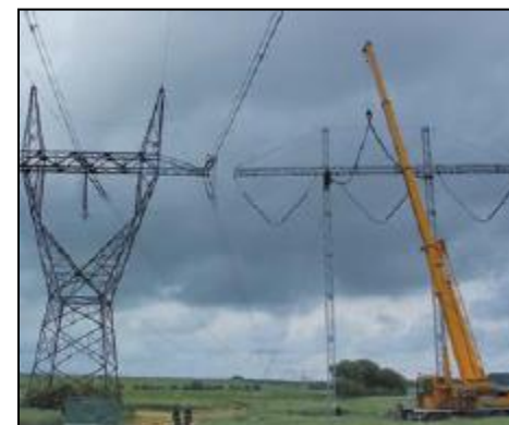
6) Montáž vodičů na provizorní vedení NPT
