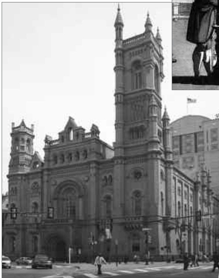
Sede della Gran Loggia di Pennsylvania a Philadelphia negli Stati Uniti
