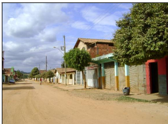
Foto 71 - Visão parcial das edificações em uma das vias que formam o povoado de Revés do Belém. O padrão construtivo das edificações é predominantemente baixo.
