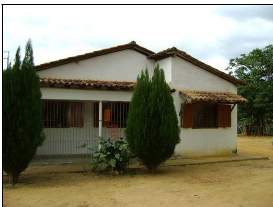
Foto 85 - Casa sede da Fazenda Lagoa Verde, edificação de bom padrão que retrata bem a tipologia maioria das sedes das propriedades locais.
