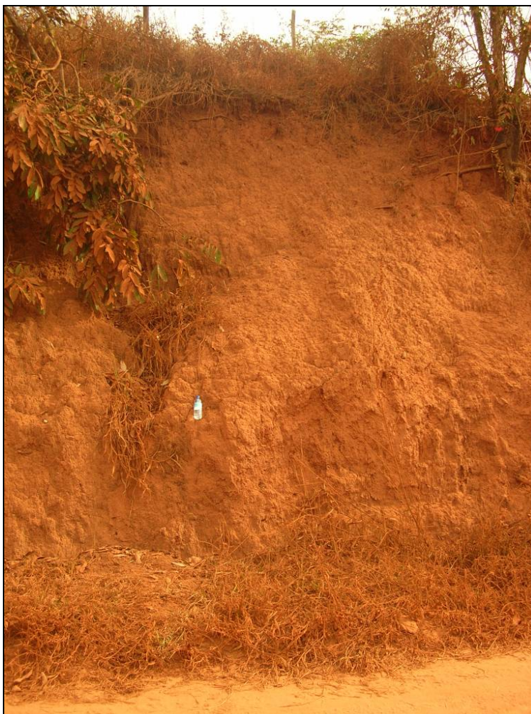
Foto 14 - Corte de talude estável em via de acesso à área.
