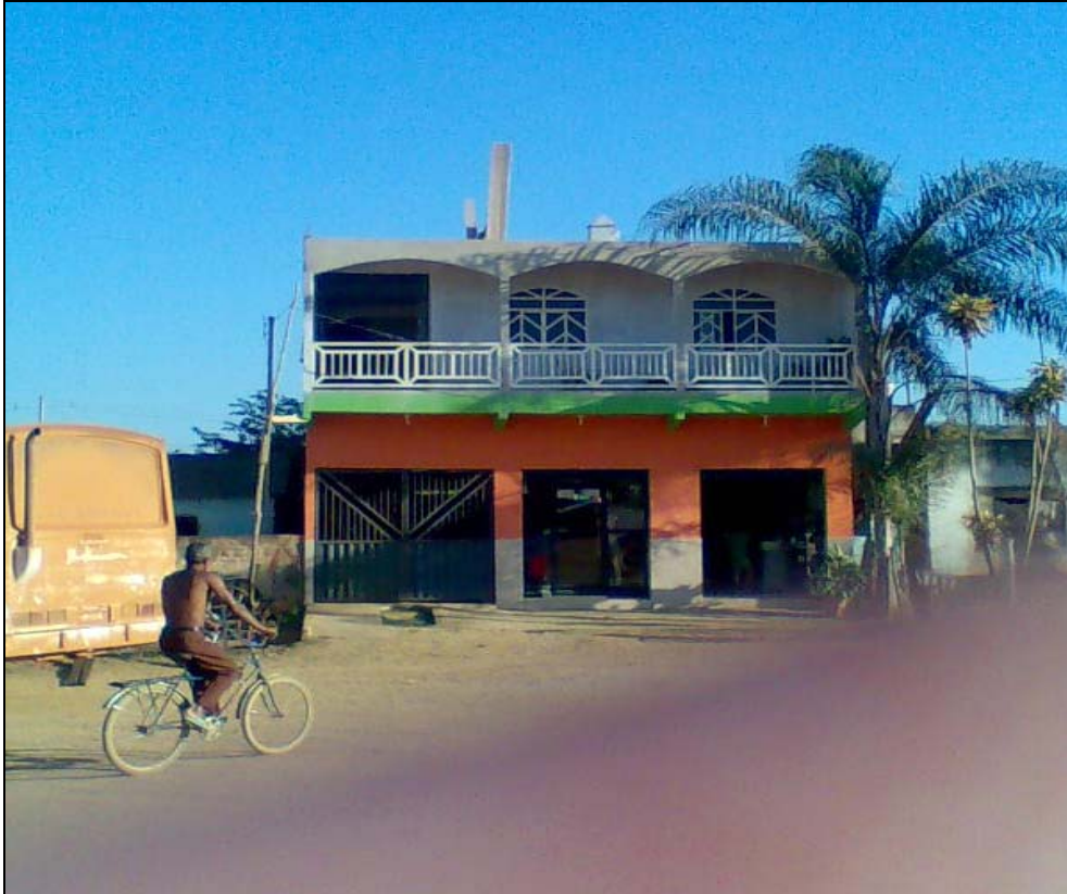
Foto 1 - Casa do Sr. Sebastião Rogério da Silva - Revés de Belém-MG - Coordenadas Geográficas: 23K - 0765608 / 7833002
