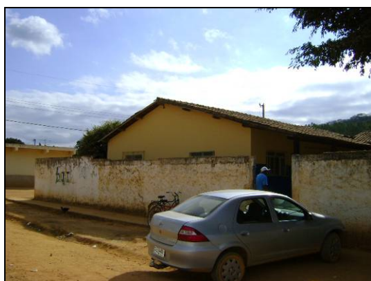
Foto 69 - Visão parcial da parte frontal da escola
