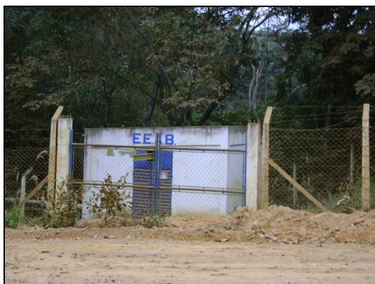
Foto 75 - Casa de máquinas utilizada para captação de água do distrito de Revés do Belém
