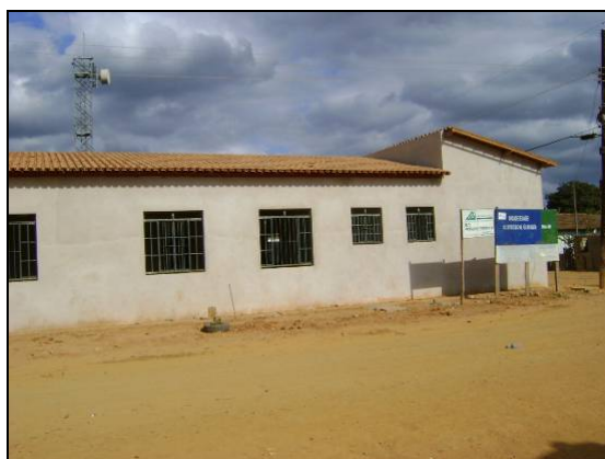
Foto 68 - Visão da estrutura onde funcionará a unidade de saúde do distrito.
