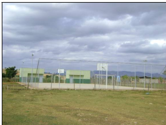
Foto 77 - Quadra poliesportiva e ao fundo a direita na foto o campo de futebol, opções de lazer e para a prática de esporte da comunidade.
