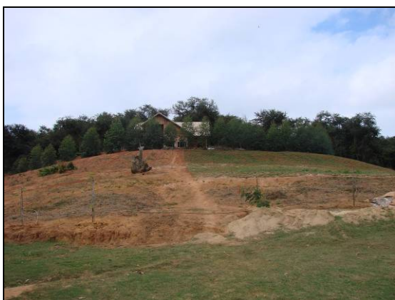
Foto 87 - Sede da Fazenda Cabiúna em fase de conclusão. Na o proprietário esta erguendo uma estrutura mais voltada para o lazer.
