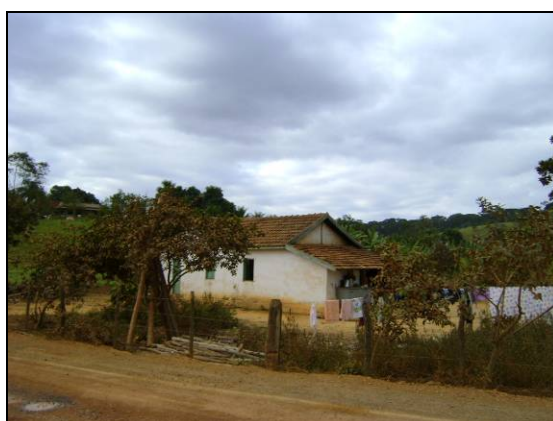
Foto 86 - Uma das casas dos empregados da Fazenda Palmeira. Residência de baixo padrão construtivo.
