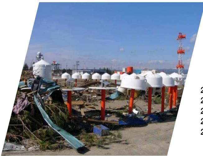
●津波により破壊されたVOR空中線
