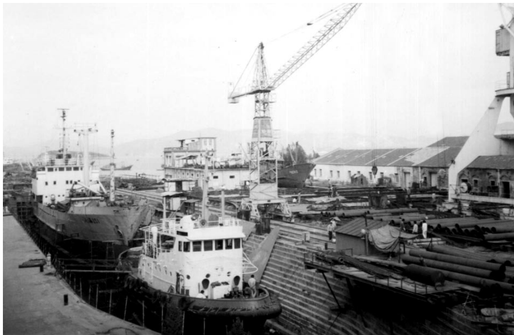
厦禾工地修船坞在修船
