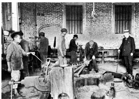
厦门新船坞公司拥有车床、冲床、起重机等设备,并且有一座修船的船台,长度约110英尺。
