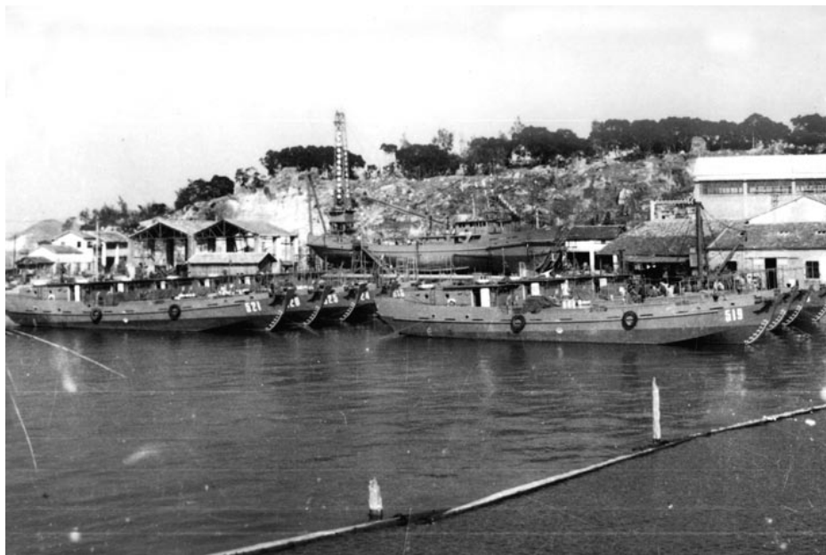
原厦门造船厂鼓浪屿工地
