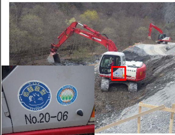
写真4-1-1 排出ガス対策型、低騒音型 建設機械の採用（一例）
