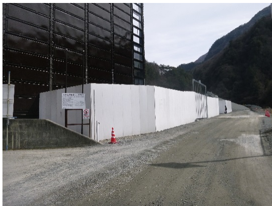
写真4-1-5 仮囲いの設置状況 （小渋川非常口）
