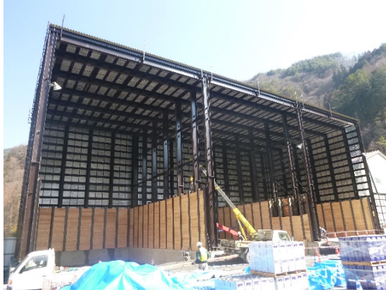
写真4-1-7 ヤード内仮置き場（重金属対応判定場）の設置状況（小渋川非常口）
