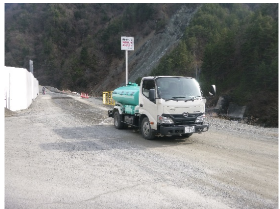
写真4-1-6 周辺道路の散水状況（一例）
