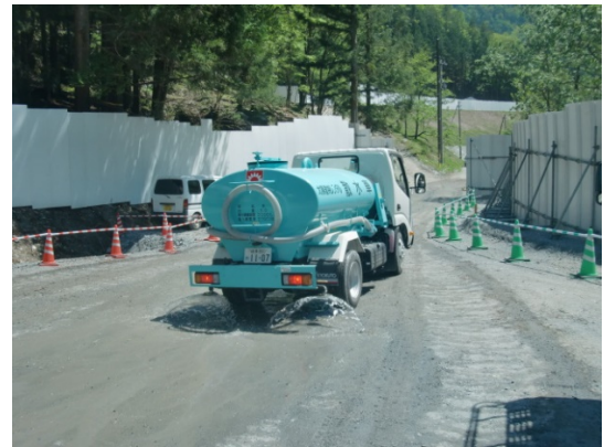
写真4-1-4 工事現場の散水状況（一例）
