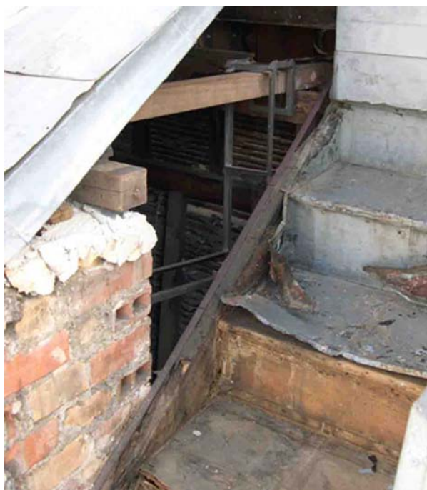
Fig.03: Escada de acesso ao interior da cúpula.
