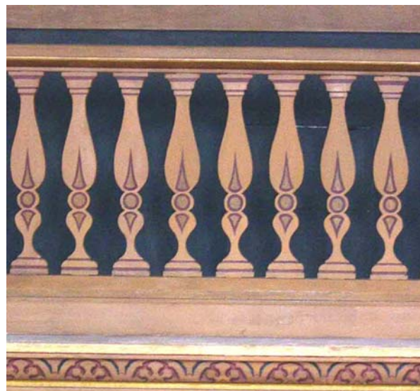
Fig. 10: Balaustrada após intervenção de restauro.
