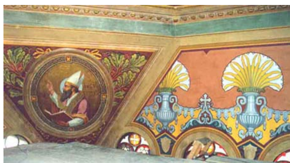
Fig.08: Painel trapezoidal e parede dos vitrais após intervenção de restauro.
