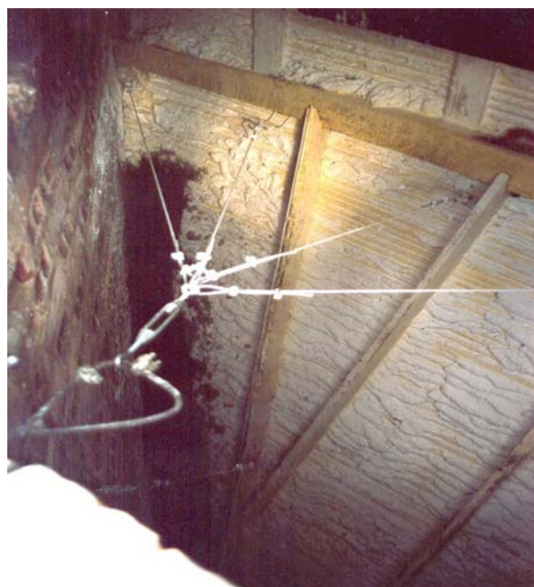
Fig.07: Cabos de aço que sustentam o painel trapezoidal, na face externa do estuque.
