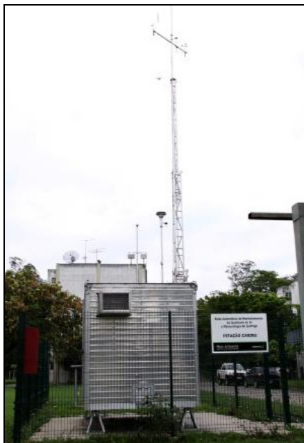
Figura 21: Container da Rede Automática de Monitoramento Contínuo da Qualidade do Ar e Meteorologia no bairro Cariru, Ipatinga – MG.
