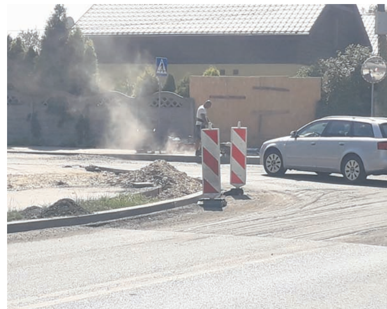
Budowa kanalizacji zakończy się w sierpniu.
