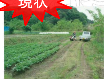
幅員狭小・未舗装の状況
