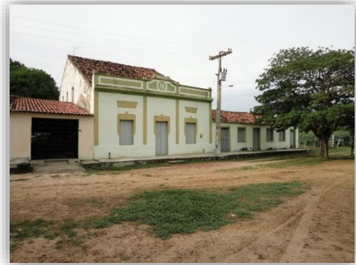
Figura 69 - Casa de moradores da Fazenda Araripe , em Araripe, Exu/PE.
