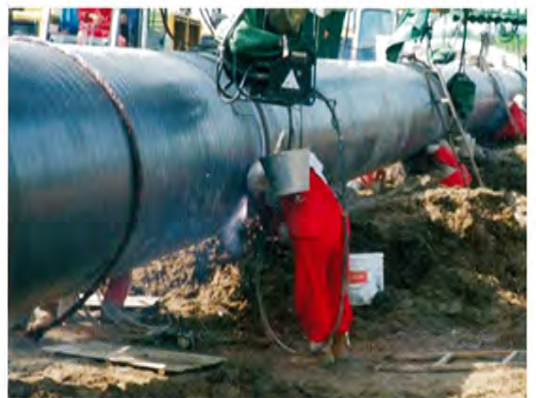
Fabshield X80焊丝用于西气东输二线, 2008年
