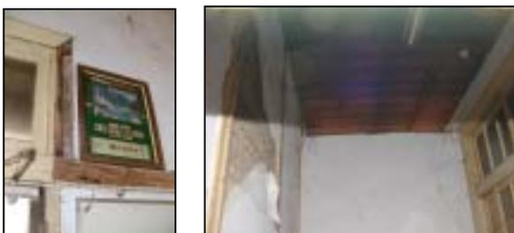
【圖】紅磚構造      【圖】廁所牆壁竹編夾灰泥
