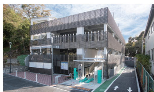
2015年に完成した大磯町駅前自転車駐輪場
