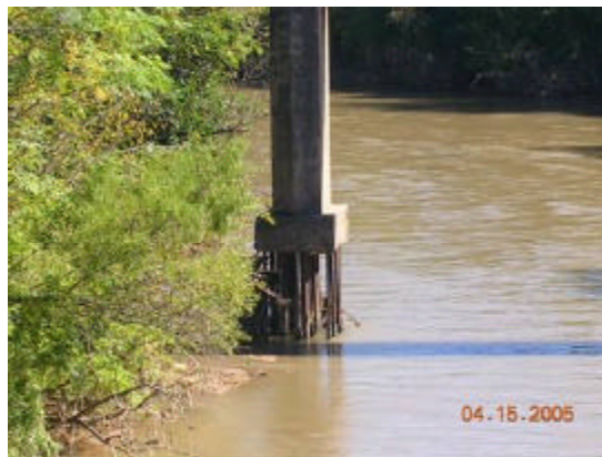
Figura 3.- Pila de Puente Canal sobre Río Segundo en Va. del Tránsito
