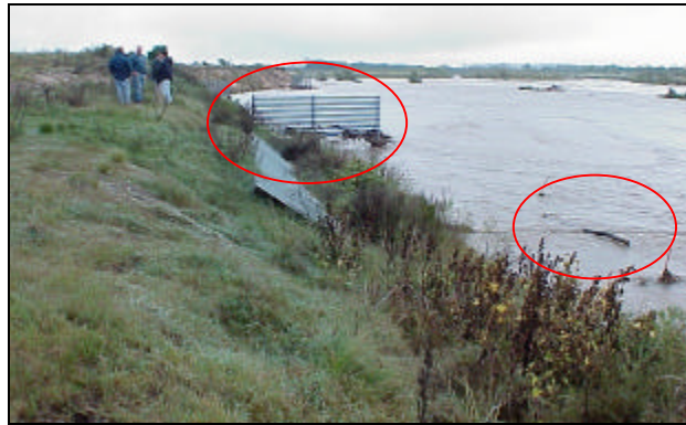
Figura 2.- Destape del poliducto REPSOL-YPF (der) y protección en margen con pantalla metálica (izq).
