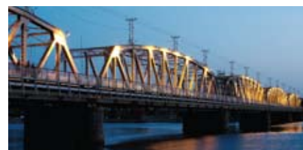
Ponte Florentino Ávidos Vitória
