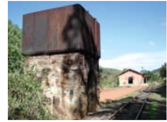
Caixa d'água e Estação de Matilde Alfredo Chaves
