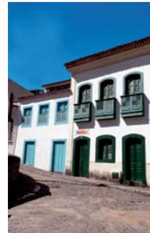
Residências à rua José Marcelino Vitória
