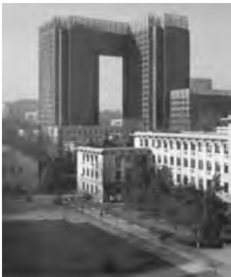
科大天工大厦暨中关村高端人才 创业基地竣工
