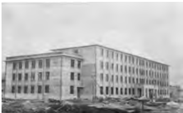
新竣工的采矿楼
