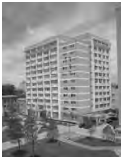
新采矿楼(土木环境楼)竣工
