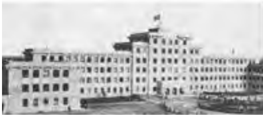
新竣工的学校中央主楼
