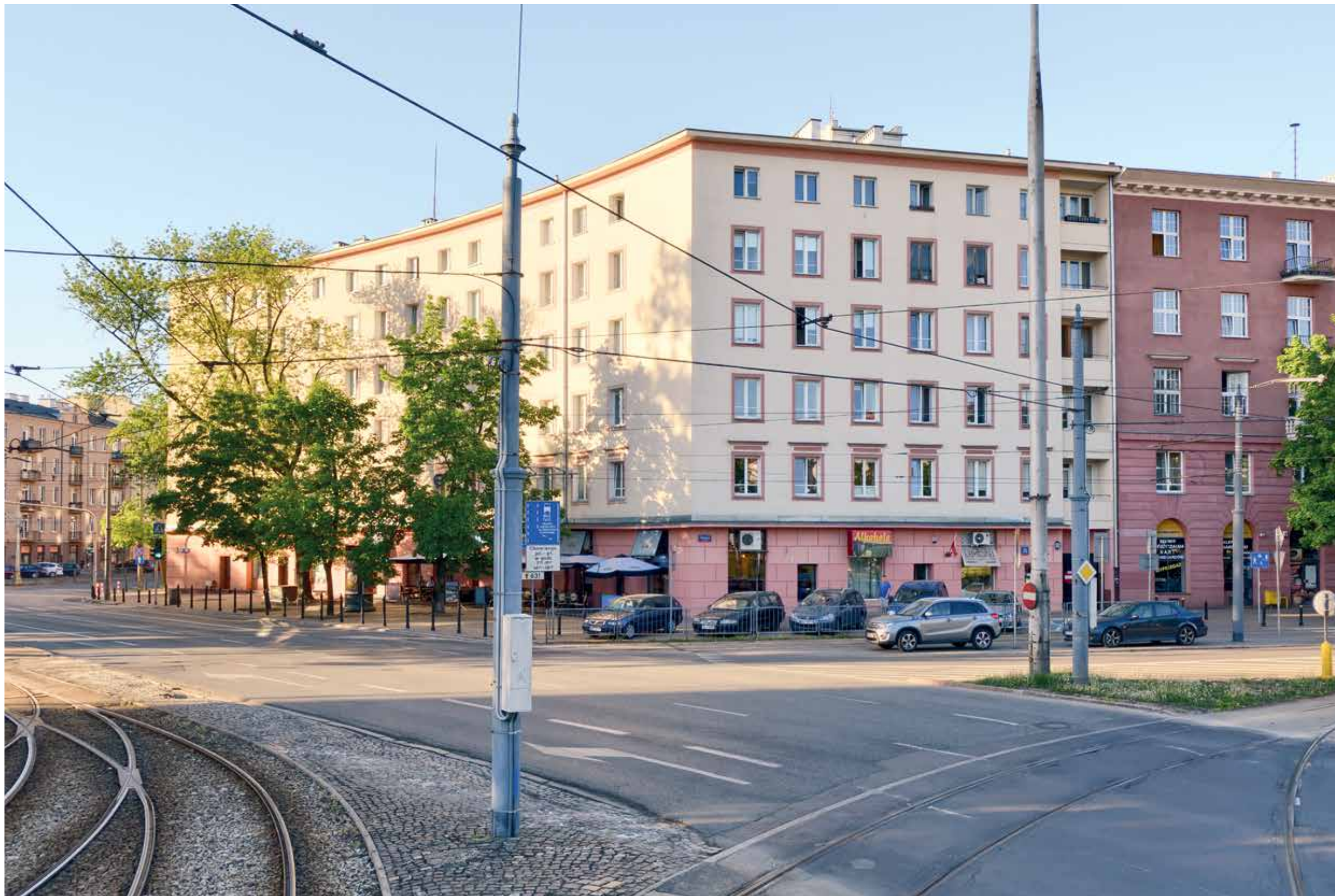
Naroznik placu Narutowicza z domami mieszkalnymi Pocztovej Kasy Oszczędności przy ul. Filtrowej 68, proj. Józef Handzelewicz, 1925-1926 r., i przy ul. Filtrowej 70, proj. Zygmunt Tillinger, 1926-1928 r., stan z 2018 r.
