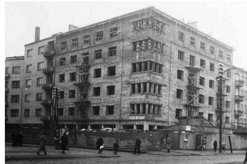
Dom Stanisława Syski, ul. Grójecka 34, proj. Fryderyk Tadanier, realiz. w l. 1937-1938; na zdjęciu obok budowa, poniżej – stan z 2018 r.
