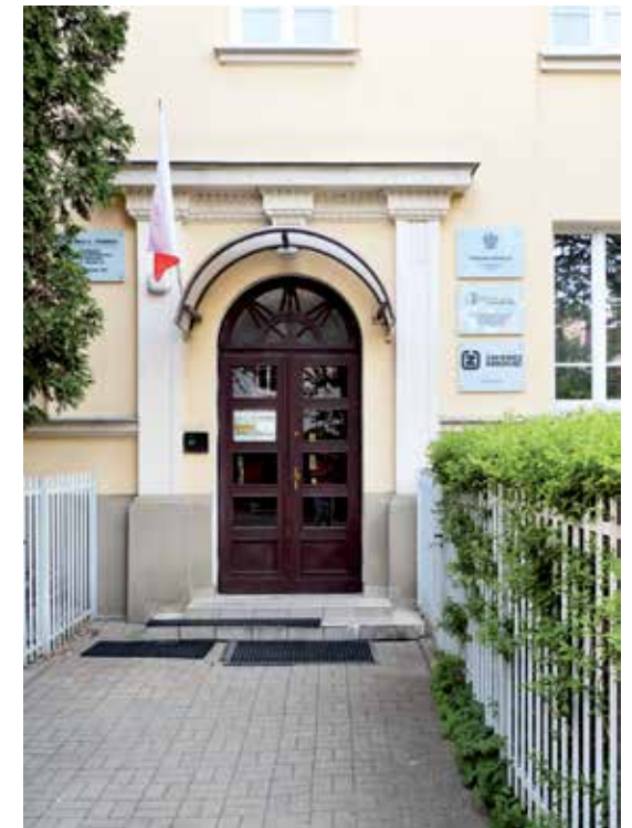
Wejście do domu przy ul. Filtrowej 30, stan z 2018 r.
