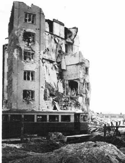
Zrujnowana kamienica na rogu Szczęśliwickiej i Opaczewskiej, w tle widoczny budynek zajezdni tramwajowej Rakowiec, 1940 r.
