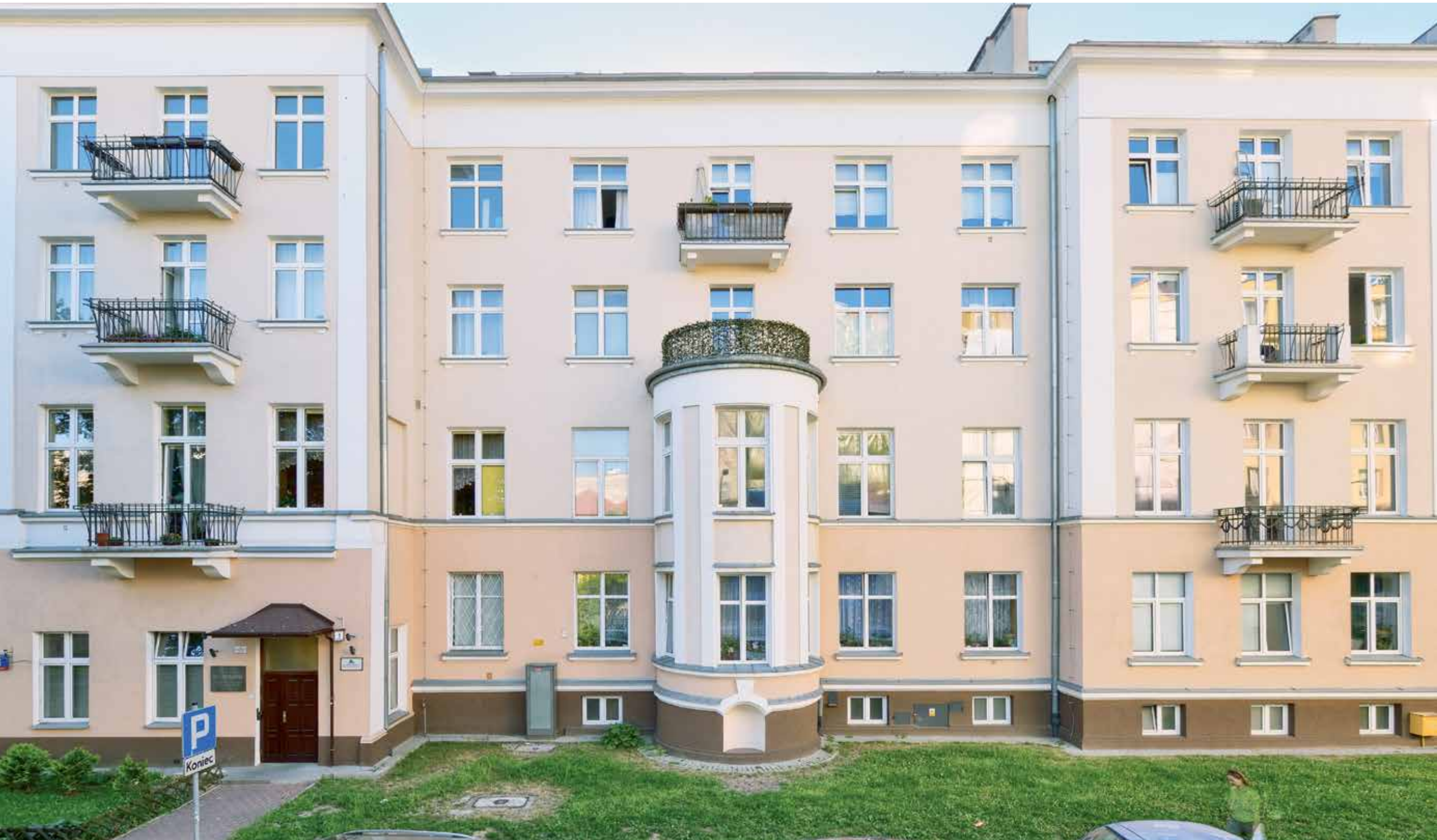
Dom administracyjno-mieszkalny dawnego Monopolu Tytoniowego, ul. Kaliska 1, stan z 2018 r.
