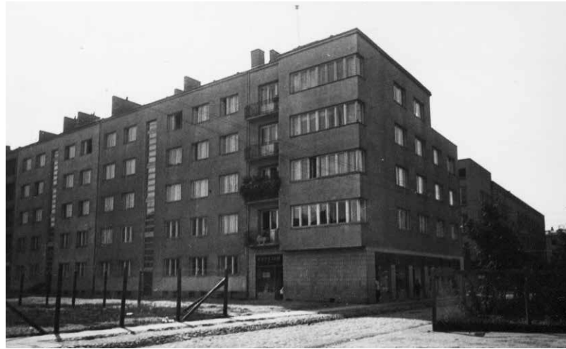
Zabudowa Radomskiej przy narożniku Białobrzeskaja, 1937 r.
