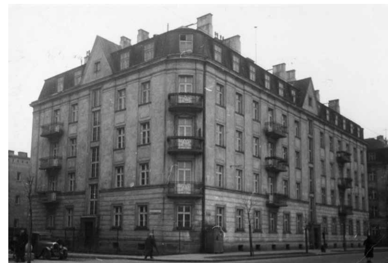
Kamienica spółdzielcza na rogu ulic Filtrowej i Solariego
