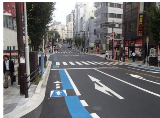
一般国道463号(県庁通り)(浦和区高砂3丁目)
