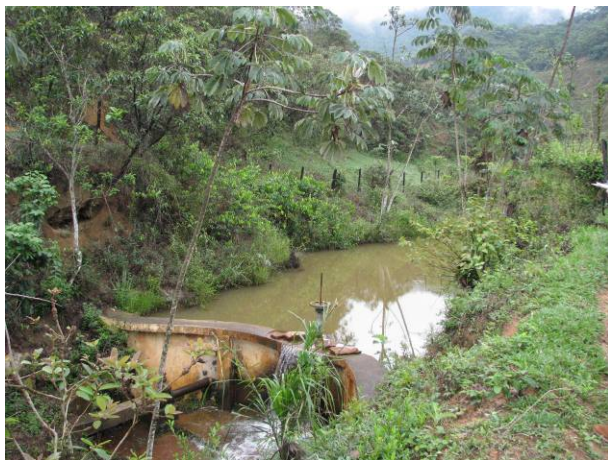
Figura 106 - Ponto de captação da sede municipal de Marliéria. Foto: Lume, 2008.
