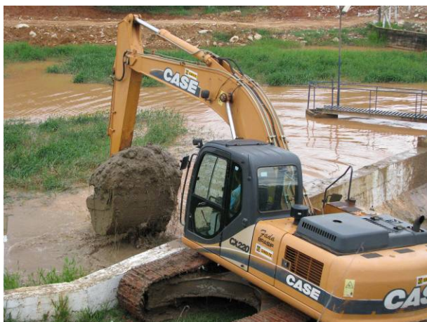
Figura 92 - Desassoreamento ambientalmente inadequado do barramento onde é captada a água. Foto: Lume, 2008.
