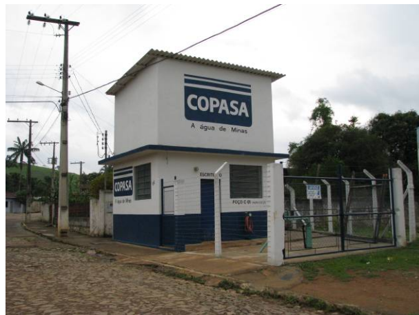
Figura 29 - Poço tubular para captação de água do distrito de Conceição de Piracicaba. Foto: Lume, 2008.
