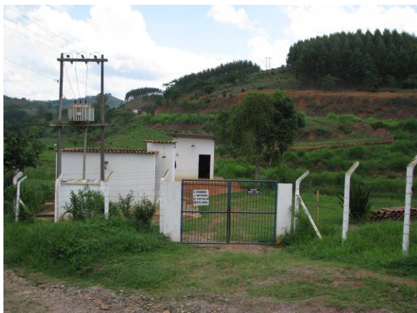
Figura 76 - Ponto onde é captada a água. Foto: Lume, 2008.
