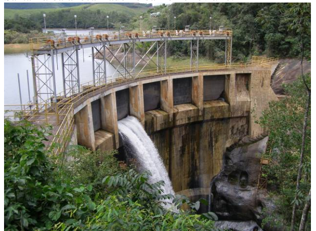
Figura 41 - Barramento da Usina Hidrelétrica de Peti. Foto: Lume, 2008.
