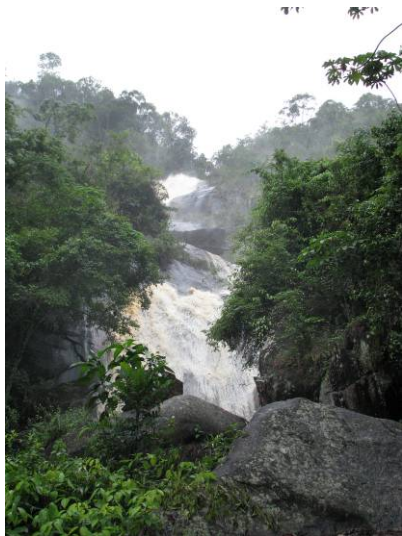
Figura 96 - Queda utilizada para a geração de energia. Foto: Lume, 2008.
