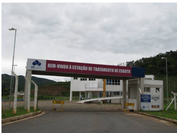
Figura 85 - ETE de Itabira. Foto: Lume, 2008.
