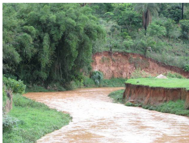
Figura 86 - Meandro do rio do Peixe com desabamento de encosta devido a falta de vegetação ciliar ao fundo. Foto: Lume, 2008.
