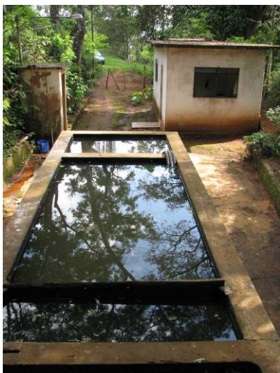
Figura 74 - Captação do DAE. Foto: Lume, 2008.
