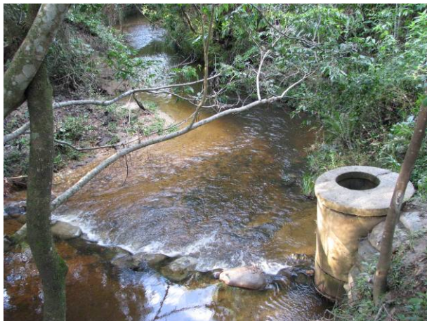
Figura 68 - Barramento para captação de água do distrito de Cocais em Barão de Cocais. Foto: Lume, 2008.
