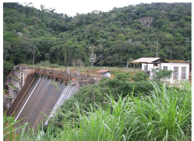
Figura 10 - PCH Amarin da Arcelor Mital em João Monlevade. Foto: Lume, 2008.
