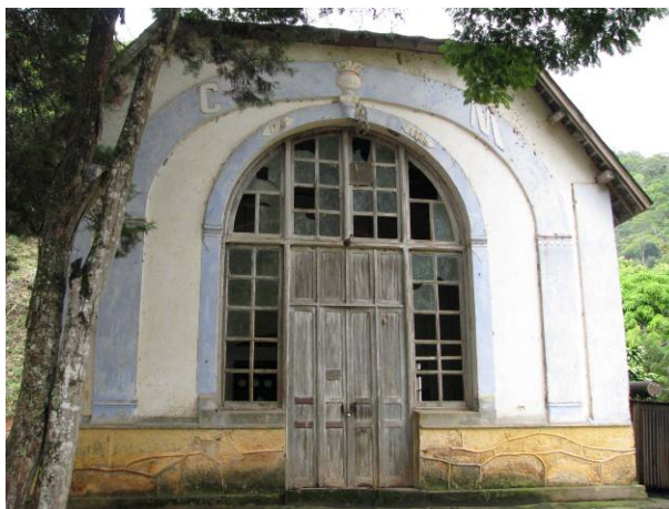
Figura 97 - Casa de força da antiga usina. Foto: Lume, 2008.
