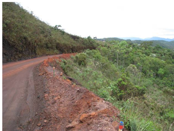
Figura 49 - Estrada de acessos as áreas das minerações à montante das nascentes do ribeirão Preto. Foto: Lume, 2008.
