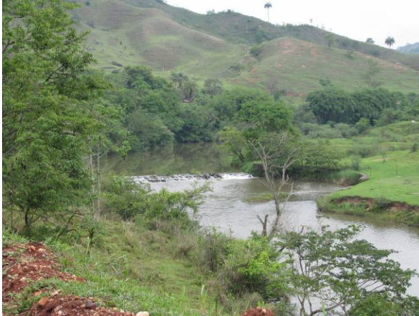
Figura 44 - Barramento a fio d'água para captação da sede municipal de João Monlevade. Foto: Lume, 2008.
