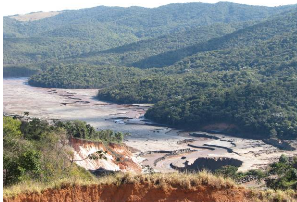
Figura 89 - Detalhe para a margem direita da barragem de Itabiruçu (reserva legal e RPPN da Vale). Foto: Lume, 2008. Foto: Lume, 2008.
