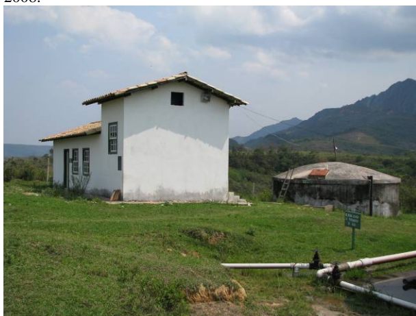
Figura 21 - Estação de Tratamento de Água de Catas Altas - ETA. Foto: Lume, 2008.
