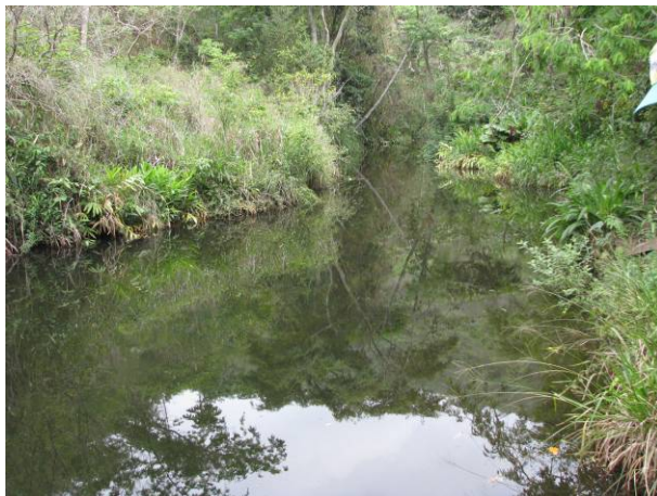
Figura 110 - Barramento para captação da água. Foto: Lume, 2008.
