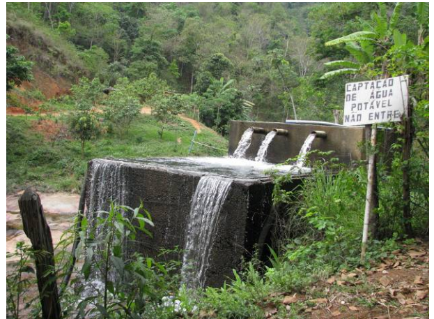
Figura 109 - Reservatório para distribuição de água. Foto: Lume, 2008.
