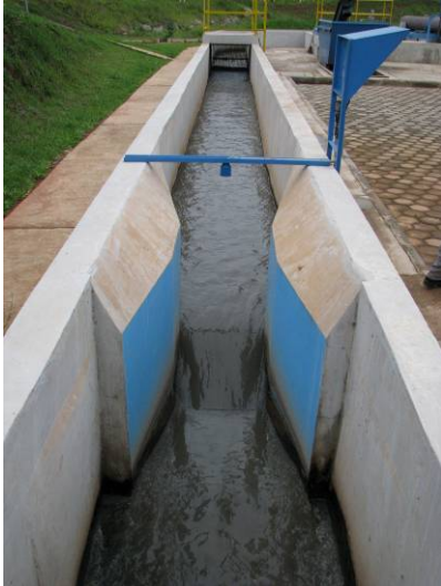
Figura 87 - Chegada do esgoto in natura . Foto: Lume, 2008.
