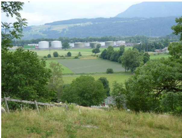
Öltanklager Sennwald mit Blick vom Bergli Kirche Sennwald in Richtung Schellenberg.
