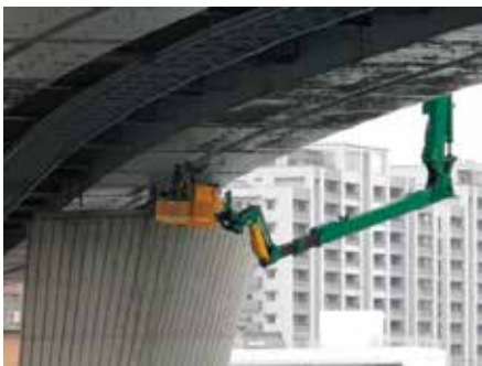
橋梁点検車・高所作業車による近接点検
