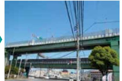
しゃ音壁（補修後—取替更新）
