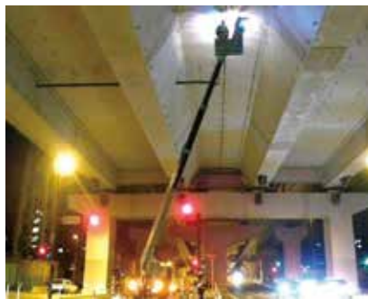
橋梁点検車・高所作業車による近接点検
