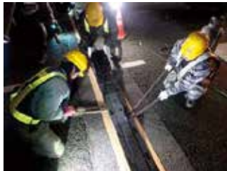
橋梁ジョイント補修
