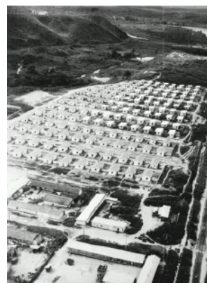
FIGURA 24- Vista parcial do Bairro Vila Ipanema Fonte: USIMINAS,1965
