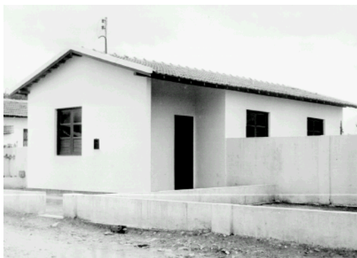
FIGURA 44- Casa tipo R1. Fonte: USIMINAS,1965
