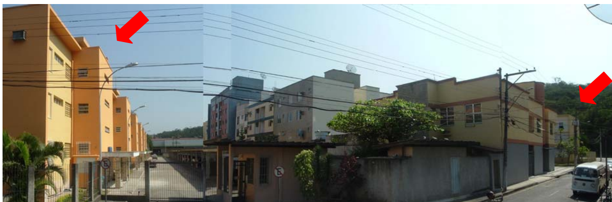
FIGURA 106 – Indicação de dois prédios previstos no plano da Vila-Operária e as construções que foram permitidas em uma rua aberta entre eles. Fonte: Arquivo particular da autora
