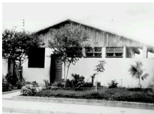
FIGURA 43- Casa tipo R. Fonte: USIMINAS,1965
