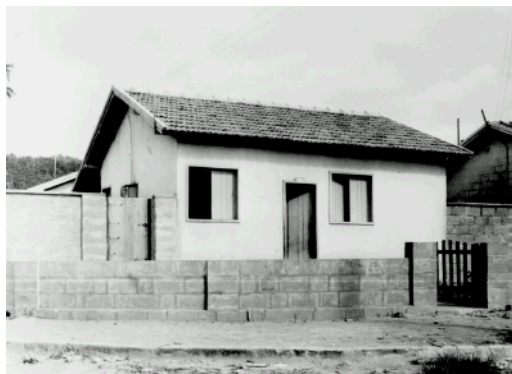
FIGURA 41- Casa tipo E1. Fonte: USIMINAS, 1965
