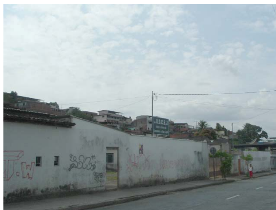
FIGURA 100 – Vista do Centro Comunitário Fonte: Arquivo particular da autora
