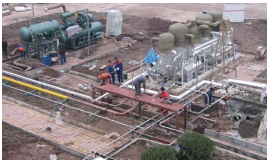
Фото 6 и 7. Процесс монтажа установки производства ОАО «Криогенмаш» по сжижению природного газа производительностью 36.0 т СПГ в сутки в Китае.
