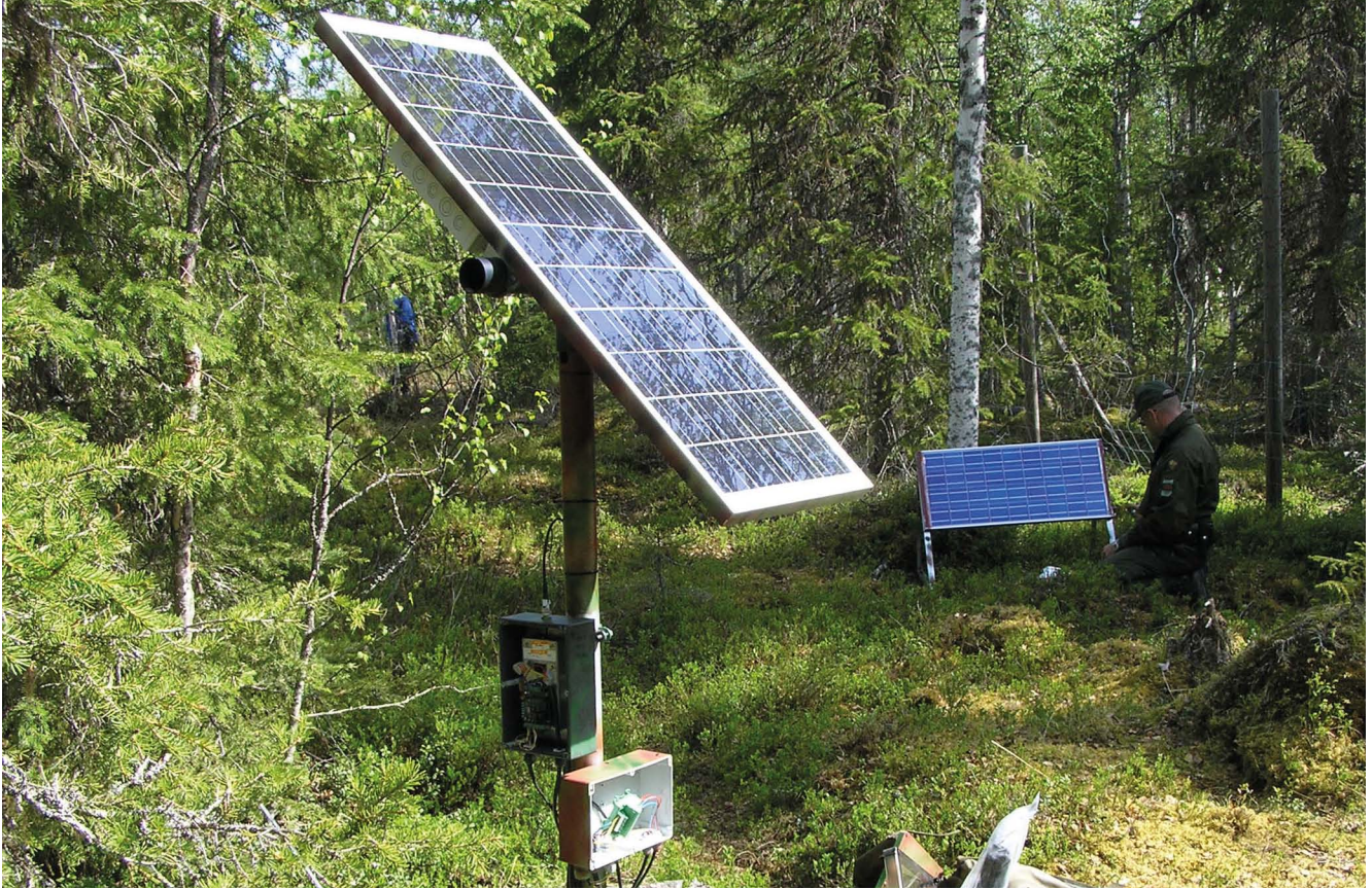
Valvontalaitteiden asennusta maastoon. Aurinkopaneelit toimivat virtalähteenä.
