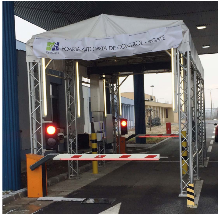
Maarajan portin suojaksi rakennettiin teltta, jolla tasoitettiin ilmasto-olosuhteita.
