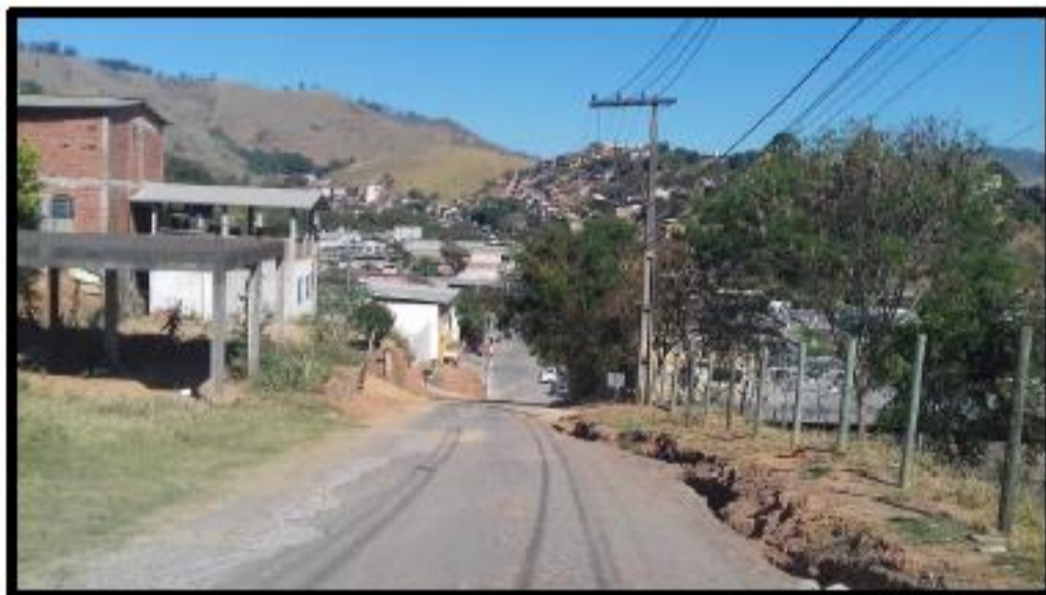
Figura 24 – Trecho com infraestrutura precária.
