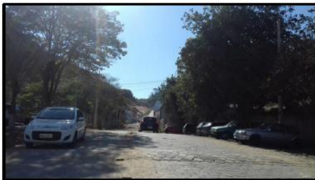
Figura 22 – Trecho com infraestrutura precária.
