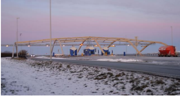
Bomstasjonen på Sokn
