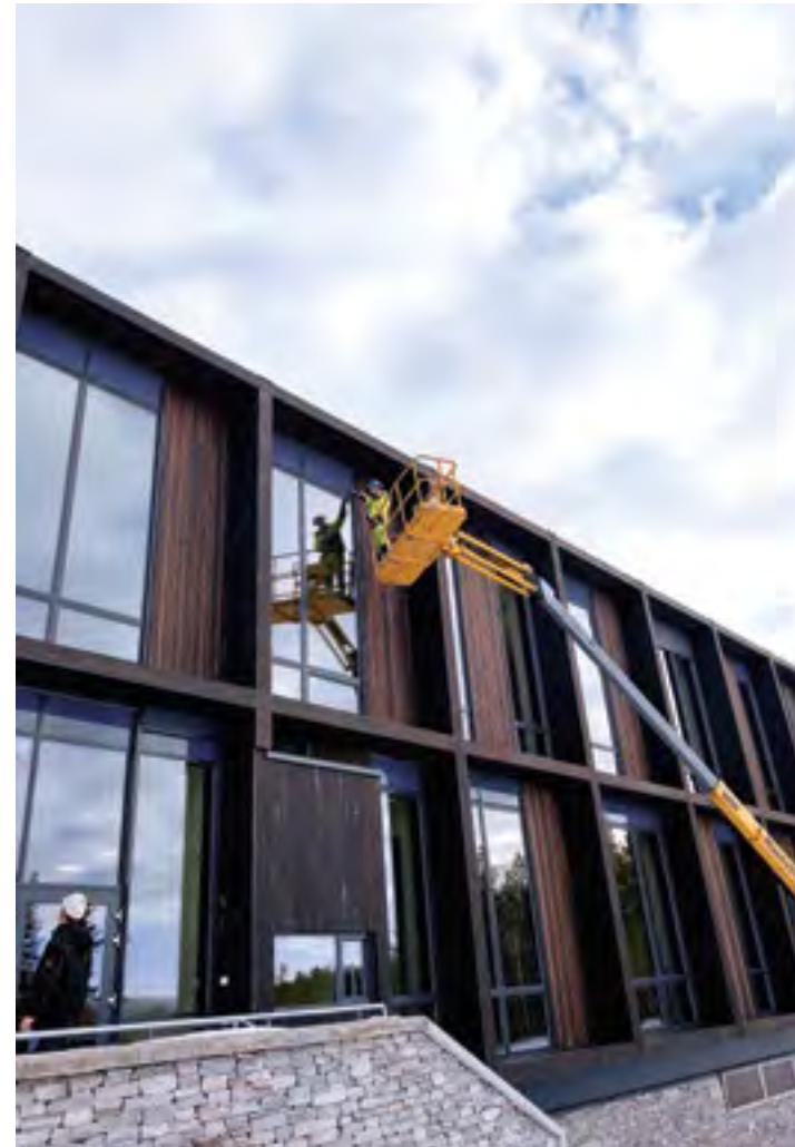
→ Raymond Vaa Vangen monterer solskjerming på ytterveggen mot sydvest. Dei høge vindauga gir fantastisk utsikt for dei ansatte på Helsearkivet, men sola kan – sjølv på Tynset – skape utfordringar for skjermarbeidarane.
