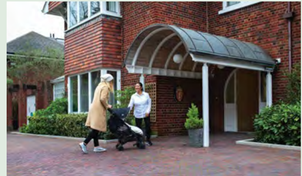
Bakken foran inngangspartiet er hevet, slik at det er trinnfri atkomst til ambassaderesidensen. Det gjør det mye hyggeligere for ambassadøren å ta imot gjester som kommer med barnevogn, i rullestol eller er dårlig til beins.
