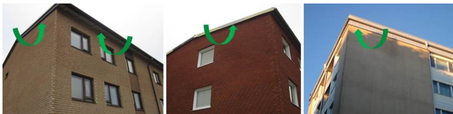
Tre exempel på häckplatser i Uppsala där pilarna visar hur tornseglarna flyger in underifrån.
