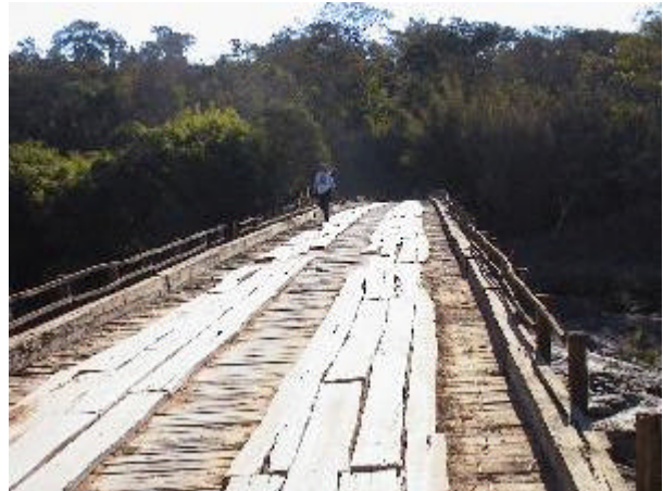
d) Ponte Queimada
