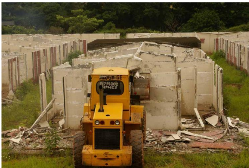
Figura 4: Demolição das habitações do bairro Alegre em Timóteo
