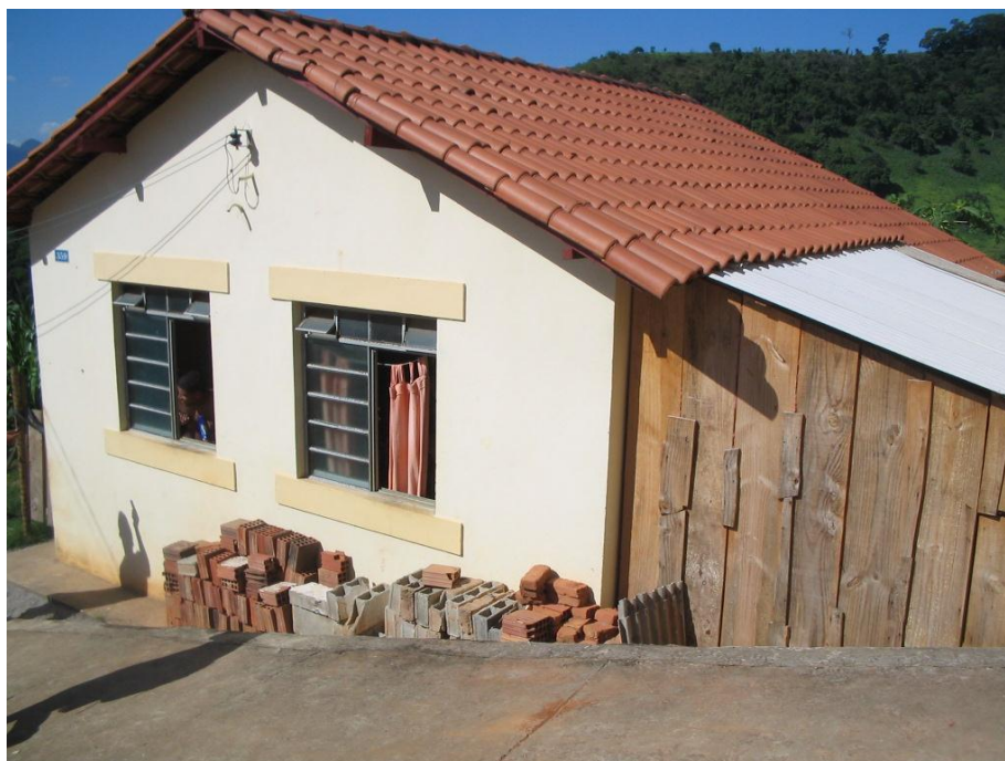
Figura 14: Ampliações realizadas no Conjunto Habitacional Bela Vista Fonte: Mapeamento realizado pela autora
