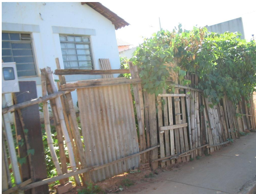
Figura 12: Construção do muro frontal
