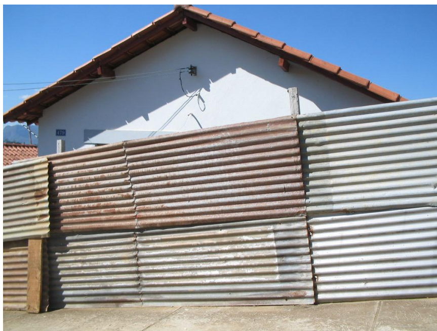
Figura 13: Construção do muro frontal
