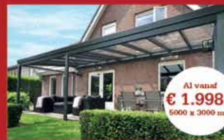
GREENLINE MET GLASDAK
