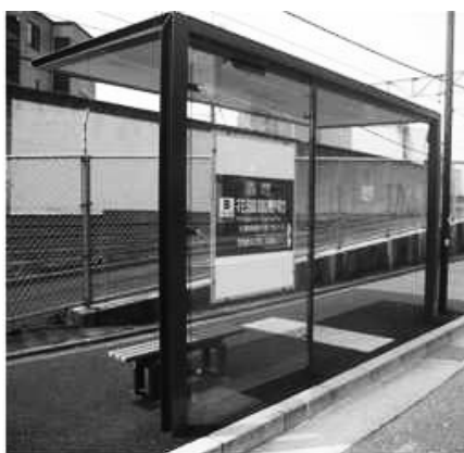
交通局による周辺部等への上屋整備 (花園扇野町 西行)
