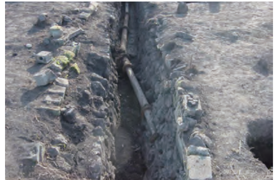
⑩石垣溝、排水管
