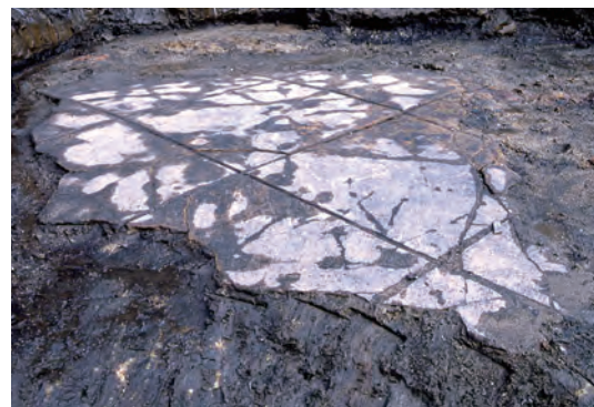
④モルタル床面
