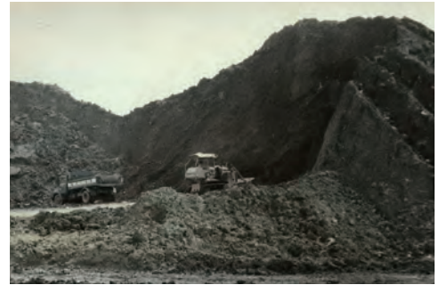
図 2-3-7 ボタ山を崩す様子
