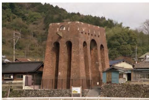
図 2-4-12 巻き上げ機台座
