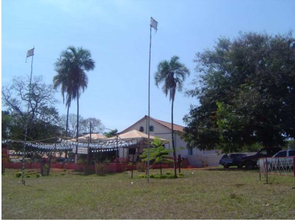
Figura 20 - Capela construída na segunda metade do século XIX
