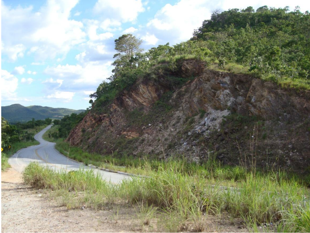
Figura 44 – Estrada asfaltada – GO 338
