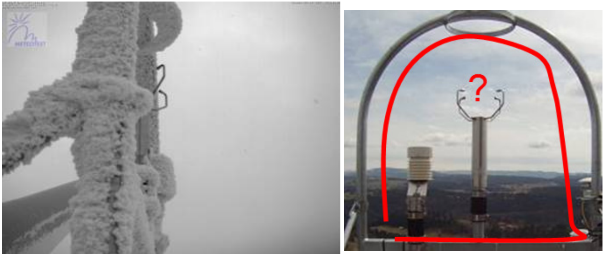
Abb. 34: Links: Eisansatz am Blitzschutz während eines starken Vereisungsereignisses. Rechts: Schematische Darstellung einer möglichen Beeinflussung der Windmessung durch starken Eisansatz am Blitzschutz.
