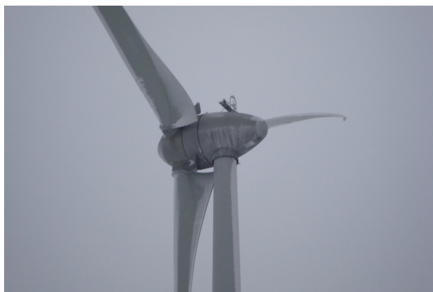
Abb. 28: WEA 1 mit abgeschalteter Blattheizung und vereisten Rotorblättern.
