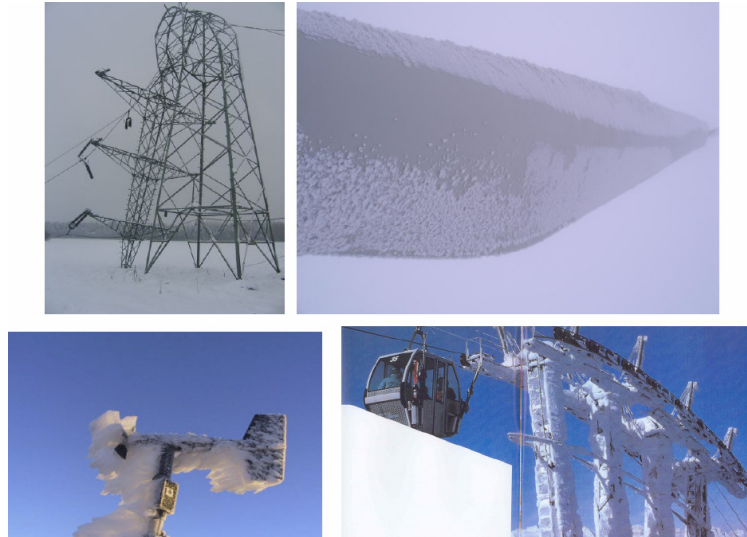
Abb. 15: Die Vereisung an Strukturen betrifft viele Bereiche. Oben links: Wegen Vereisung eingestürzter Mast einer Hochspannungsleitung. Oben rechts: Vereisung am Rotorblatt einer WEA. Unter links: Vereistes Propelleranemometer. Unter rechts: Vereisung am Mast einer Seilbahn.
