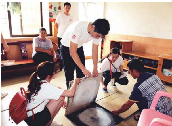
青委成员帮助61岁的孤寡、视障老人潘柱福修缮家里松动的地板。
