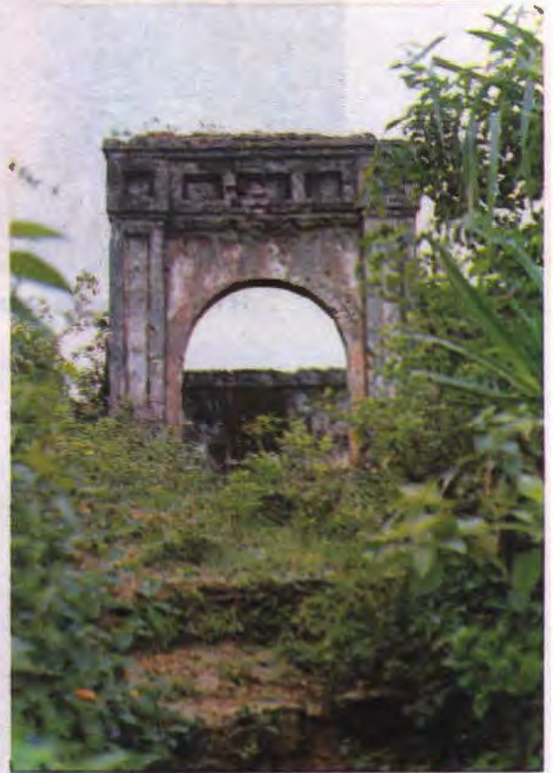
H.12. Cổng vào lăng Vĩnh Thái (của Thế Tông Hoàng Hậu), tường bên đã sập
