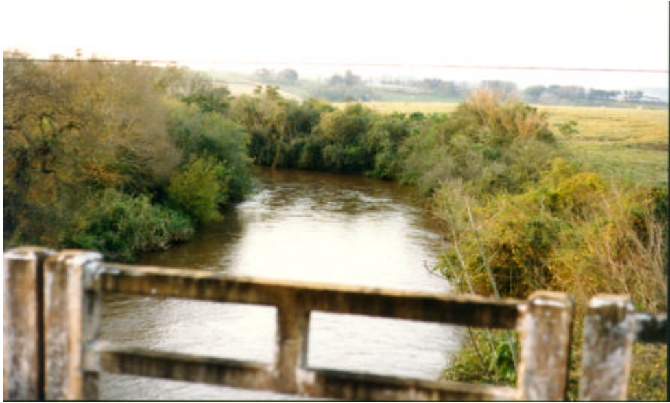
FIG. 1. Rio Melissa - a montante do reservatório da PCH Melissa.
