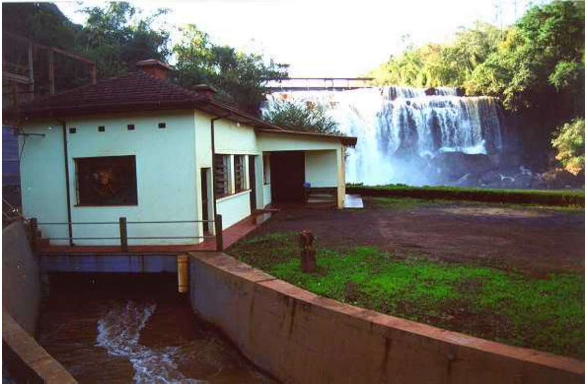
Usina e canal de fuga
