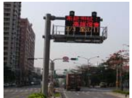
路口資訊可變標誌設施
