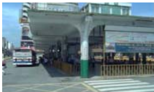
公車火車站改建前
