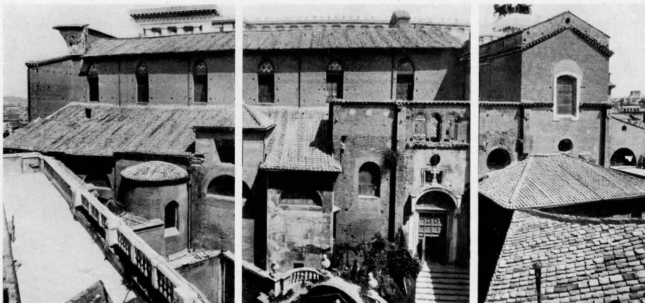
FIG. 10 - ROMA, S. M. IN ARACOELI - STATO ATTUALE DEL FIANCO SUD
