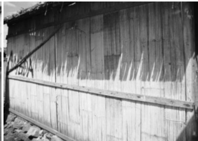
Gambar 6.2 Rumah dinding bambu
