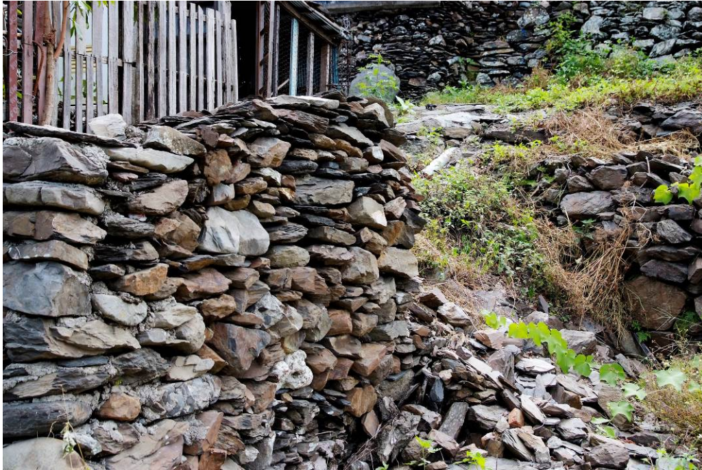
圖 71 屏東縣春日鄉老七佳石板屋底座岩石排列 (照片提供:研究者拍攝)
