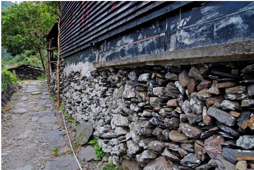
圖 72 屏東縣春日鄉老七佳石板屋底座岩石排列 (照片提供:研究者拍攝)
