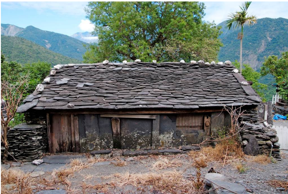
圖 68 屏東縣春日鄉老七佳石板屋背面照 (照片提供:研究者拍攝)
