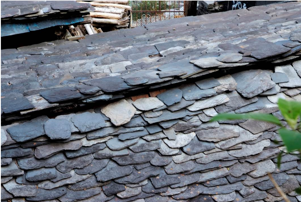
圖 69 屏東縣春日鄉老七佳石板屋屋頂頁岩排列 (照片提供:研究者拍攝)
