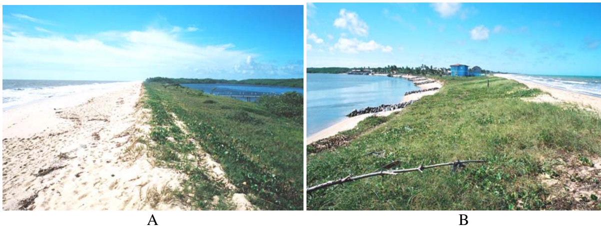
Figura 35 – Linha de costa com alta variabilidade. A – trecho estreito no pontal arenoso associado ao rio Jucuruçu sujeito à ruptura; B – esporão arenoso associado ao rio Itanhém com possibilidade de ruptura (ver figura 32 para localização das fotos).
