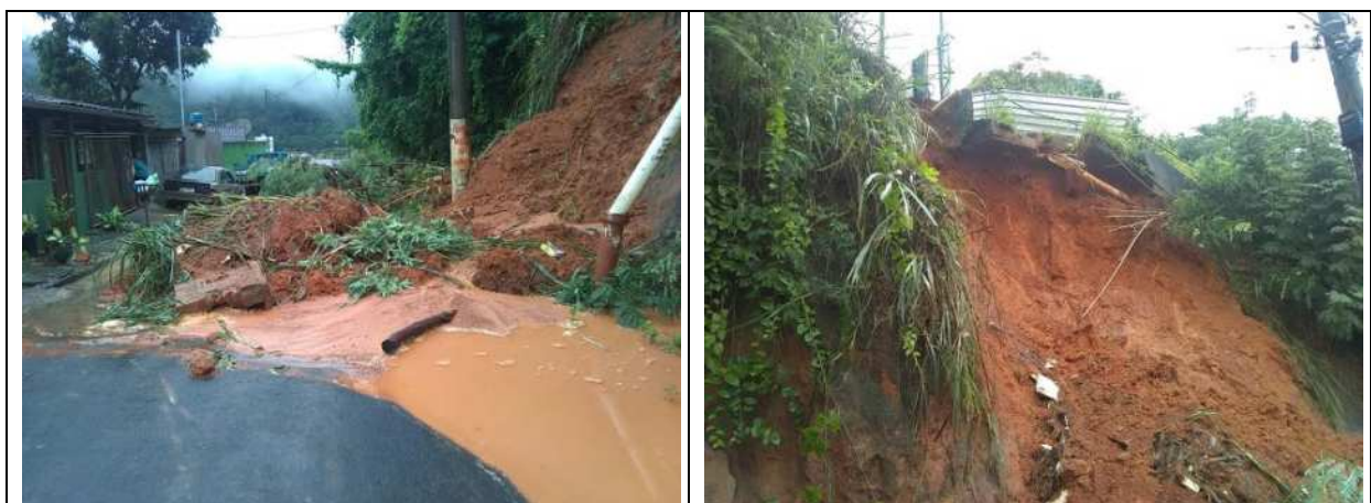
FIGURA 3.73: DESLIZAMENTO DE ENCOSTA COM OBSTRUÇÃO DE VIA NO BAIRRO ALVORADA. COORDENADA UTM 23S 746.010 E 7.836.733. Fonte: TIMÓTEO, 2020f.
