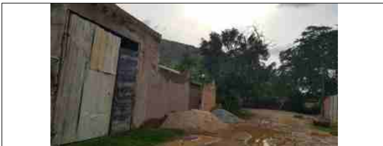
FIGURA 6.20: VISTA DE VIA IRREGULAR EM OCUPAÇÃO IRREGULAR NO BAIRRO LIMOEIRO Fonte: ECOTÉCNICA-DETZEL, 2019.
