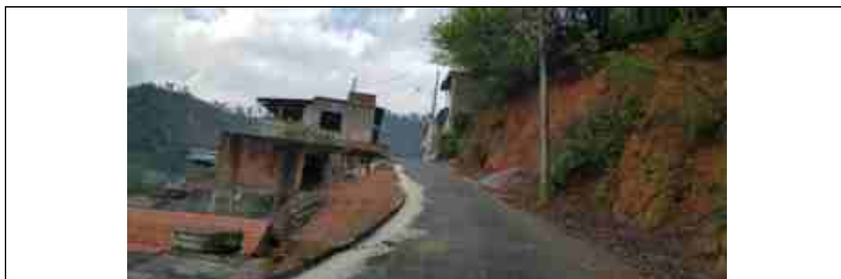
FIGURA 7.19: HABITAÇÃO EM ENCOSTA NO BAIRRO ALVORADA Fonte: ECOTÉCNICA-DETZEL, 2019.
