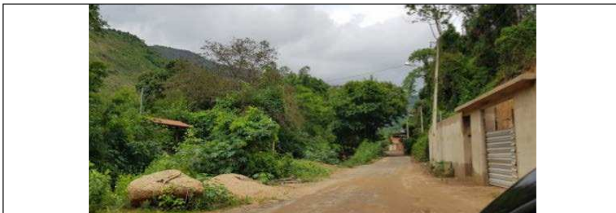
FIGURA 6.10: VISTA DA RUA LINDA NO BAIRRO PETRÓPOLIS – SEM PAVIMENTAÇÃO Fonte: ECOTÉCNICA-DETZEL, 2019.
