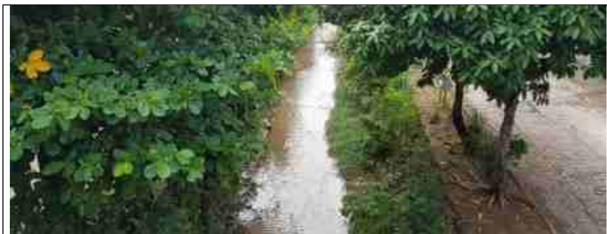
FIGURA 3.95: VIA PARALELA A RIO SEM VEGETAÇÃO ADEQUADA PARA PROTEÇÃO DA APP, NAS COORDENADAS SIRGAS 2000 23S 745.635,5 E 7.836.726,8. Fonte: ECOTÉCNICA-DETZEL, 2020.
