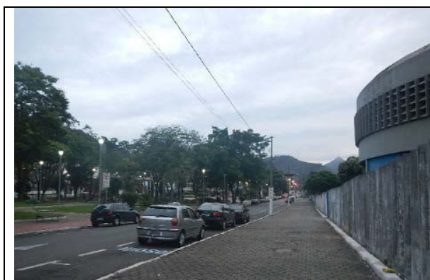
FIGURA 6.47: VISTA DE POSTES DE ILUMINAÇÃO PÚBLICA Fonte: ECOTÉCNICA-DETZEL, 2019
