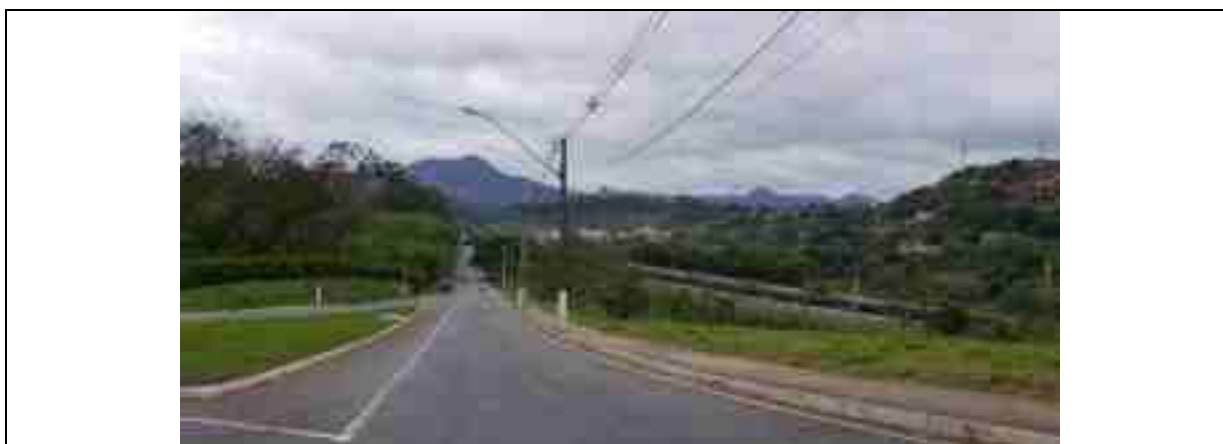
FIGURA 6.35: VISTA DA BR-381 E EFVM NA MARGEM ESQUERDA NO TREVO DE ACESSO DA AVENIDA EMALTO Fonte: ECOTÉCNICA-DETZEL, 2019.
