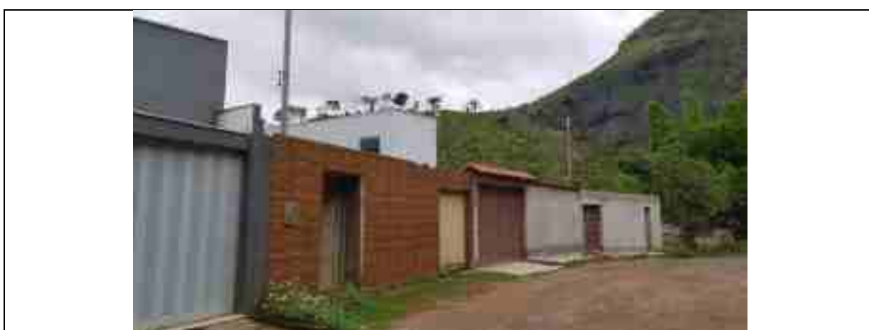
FIGURA 6.12: VISTA DA AVENIDA PETRÓPOLIS NO BAIRRO PETRÓPOLIS COM PAVIMENTAÇÃO DE CASCALHO Fonte: ECOTÉCNICA-DETZEL, 2019.
