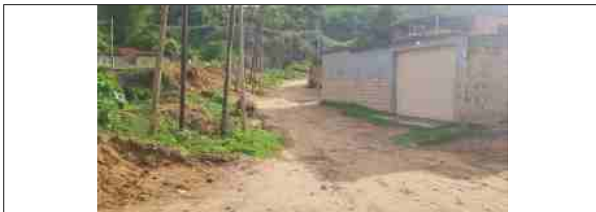
FIGURA 6.4: VISTA DA ESTRADA NO BAIRRO LIMOEIRO Fonte: ECOTÉCNICA-DETZEL, 2019.
