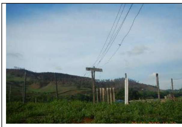
FIGURA 6.49: VISTA DE POSTE DE MADEIRA Fonte: ECOTÉCNICA-DETZEL, 2019
