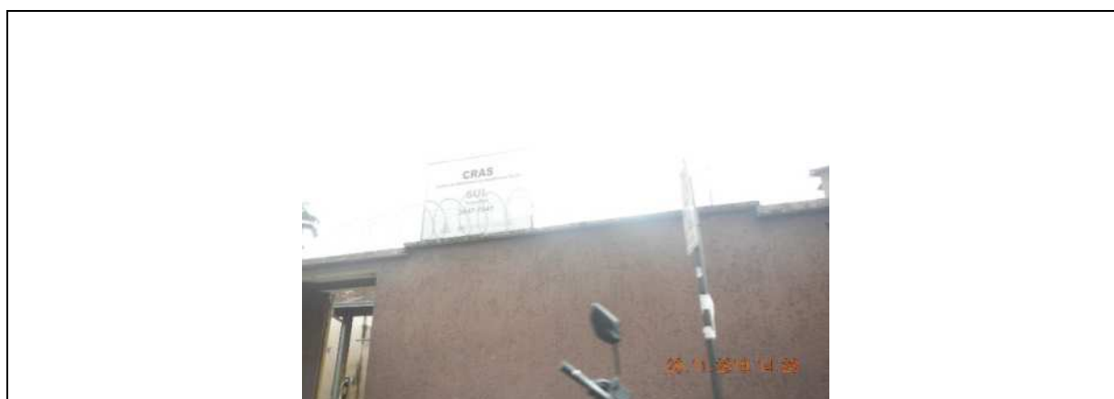
FIGURA 7.4: VISTA DA FACHADA DO CRAS SUL
