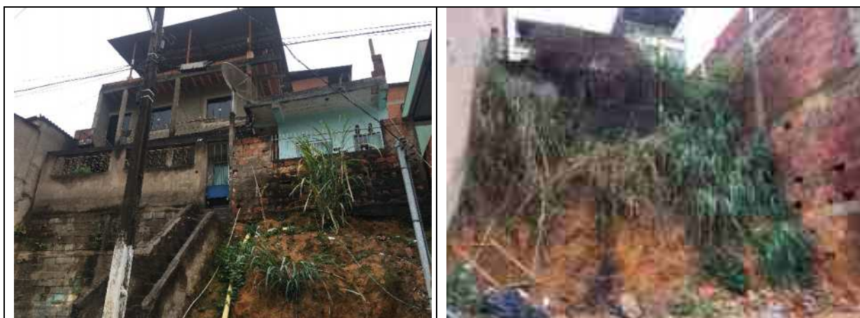
FIGURA 3.94: RESIDÊNCIAS LOCALIZADAS EM APP DE ENCOSTA, NAS COORDENADAS SIRGAS 2000 UTM 23S 748.105,4 E 7.835.379,2 (ESQUERDA) E 748.148,0 E 7.835.364,2 (DIREITA). Fonte: ECOTÉCNICA-DETZEL, 2020.
