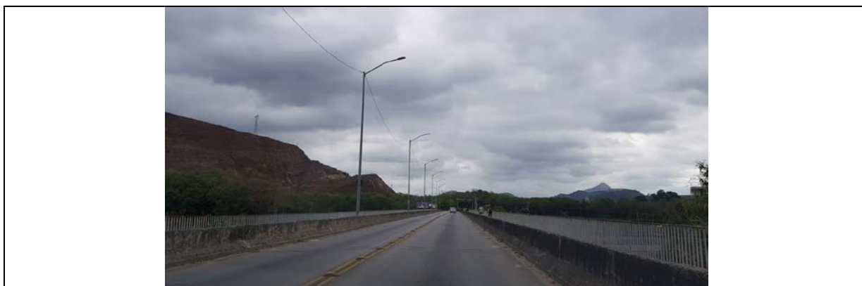
FIGURA 6.22: VISTA DA PONTE NOVA Fonte: ECOTÉCNICA-DETZEL, 2019.
