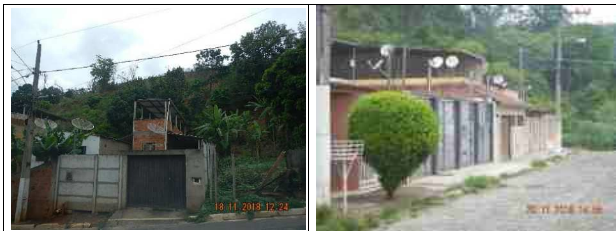
FIGURA 6.54: VISTAS DE ANTENAS PARABÓLICAS
