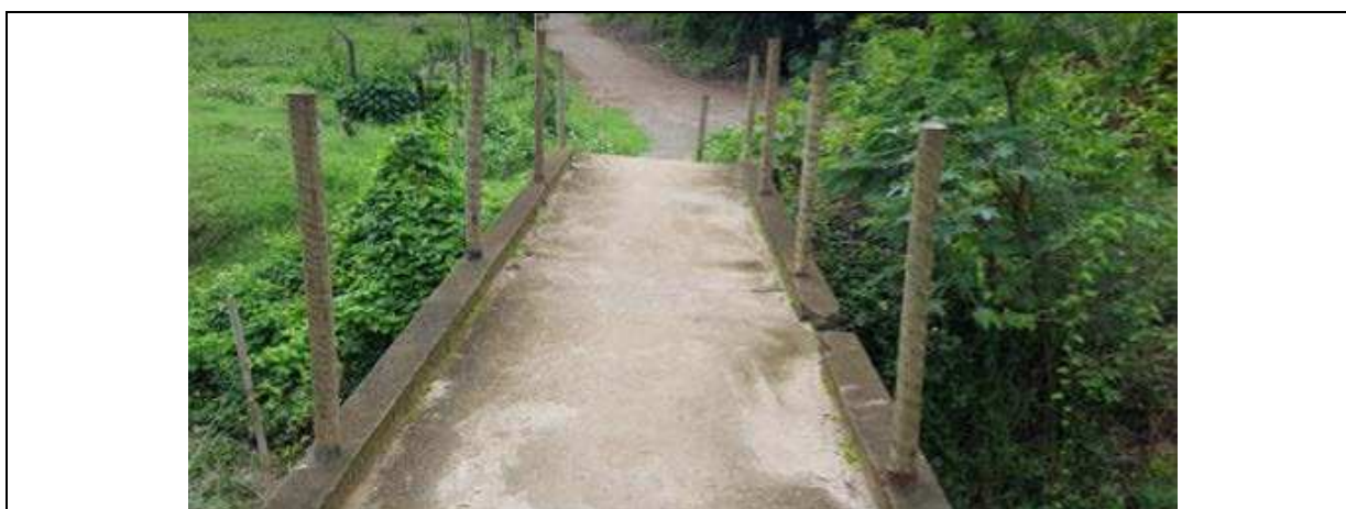
FIGURA 6.23: VISTA DE PONTE DE PEDESTRES NO BAIRRO PETRÓPOLIS Fonte: ECOTÉCNICA-DETZEL, 2019.
