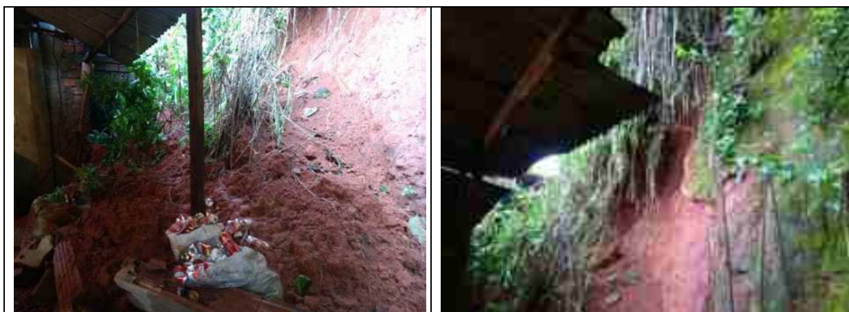
FIGURA 3.74: DESLIZAMENTO DE ENCOSTA CAUSANDO DANOS EM RESIDÊNCIA NO BAIRRO CACHOEIRA DO VALE. COORDENADA UTM 23S 744.550 E 7.836.136. Fonte: TIMÓTEO, 2020f.
