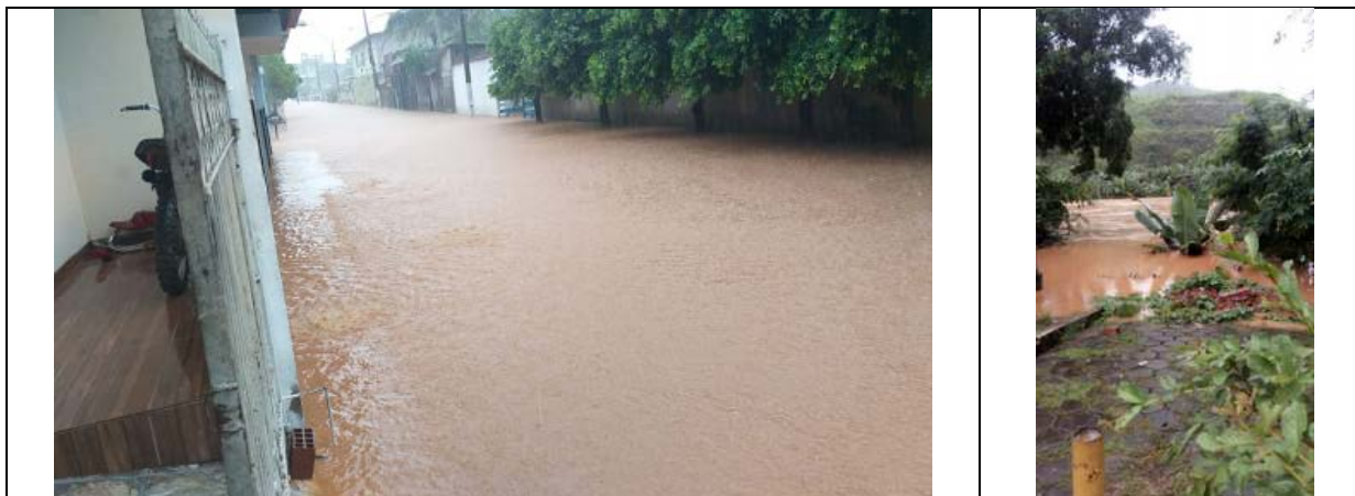
FIGURA 3.77: ALAGAMENTO REGISTRADO NO BAIRRO CACHOREIRA DO VALE. COORDENADA UTM 23S 744.786 E 7.838.807.
