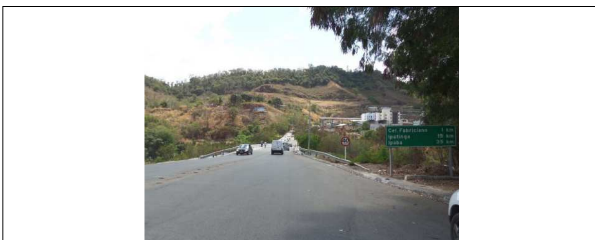
FIGURA 6.21: VISTA DA PONTE VELHA SOBRE O RIO PIRACICABA Fonte: ECOTÉCNICA-DETZEL, 2019.
