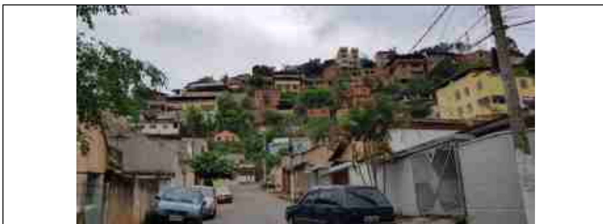
FIGURA 6.17: VISTA DAS CALÇADAS OBSTRUÍDAS POR VEÍCULOS NO BAIRRO ALVORADA Fonte: ECOTÉCNICA-DETZEL, 2019.
