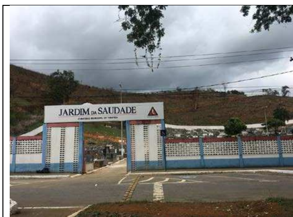
FIGURA 6.55: VISTA DA ENTRADA DO CEMITÉRIO MUNICIPAL JARDIM DA SAUDADE Fonte: ECOTÉCNICA-DETZEL, 2019
