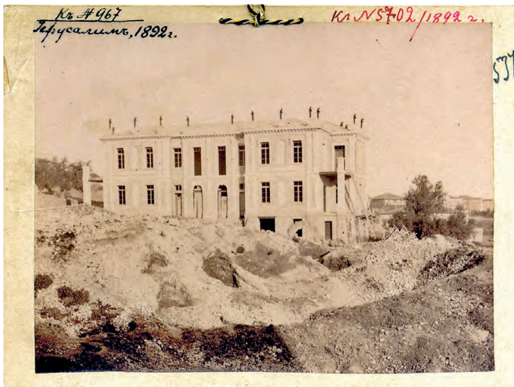
Рис. 6. Консульский дом в процессе строительства, 1892 г. АВПРИ.
