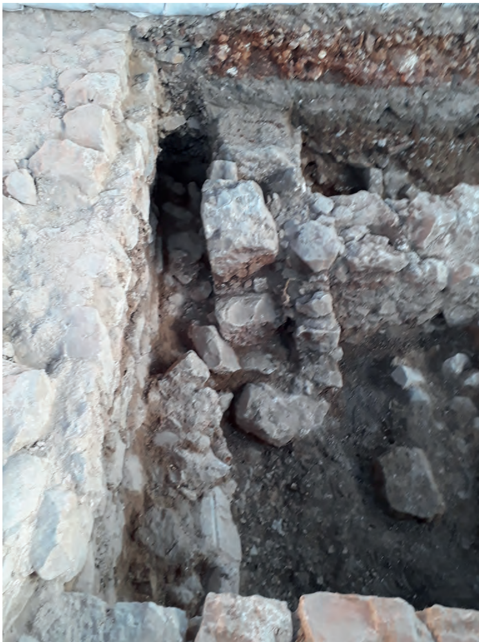
Рис. 6. Траншеи фундамента позднего здания, перерезающие стены византийского слоя. Вид с юга. Fig. 6. Byzantine wall cut by the foundations of the 19 th century structure; view north
