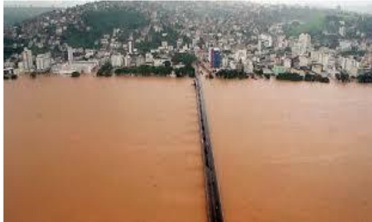
Figura 2 - Vista do Rio Doce pela ponte velha. Inundação de dezembro de 2013. Fonte: Notícias UOL (2013).
