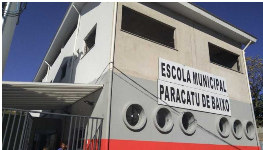
Figura 3. Estrutura temporária da escola Municipal de Paracatu de Baixo.
