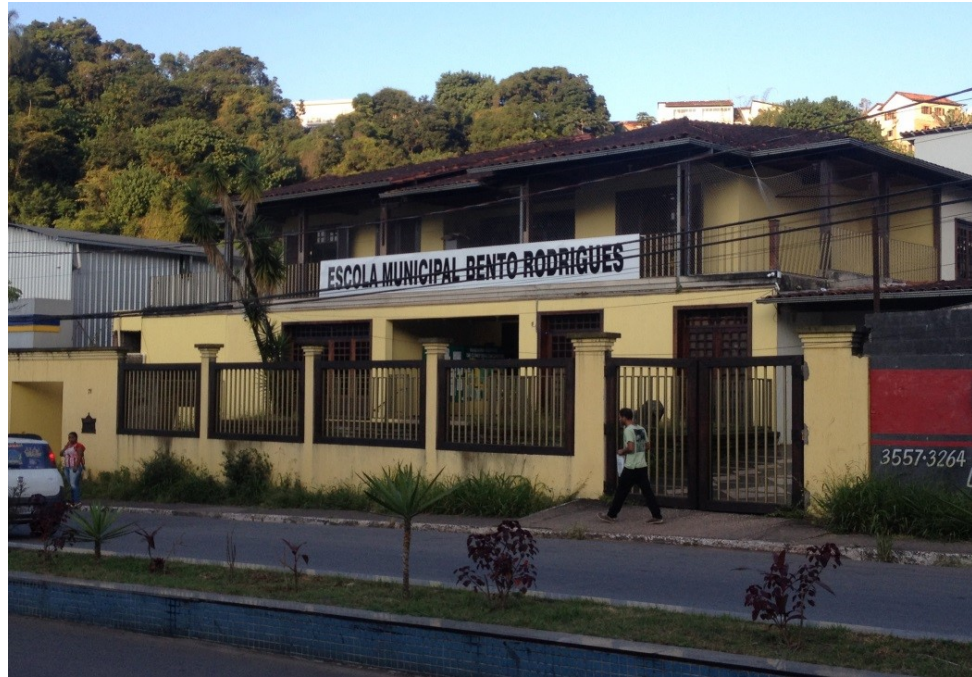
Figura 4. Estrutura temporária da Escola Municipal Bento Rodrigues
